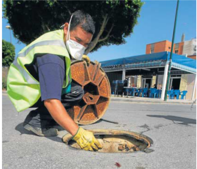
Campaña de desinfección en las alcantarillas.
