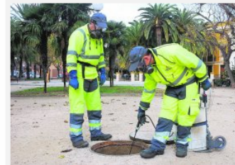
Técnicos aplicando un tratamiento insecticida en el alcantarillado. :: LP
