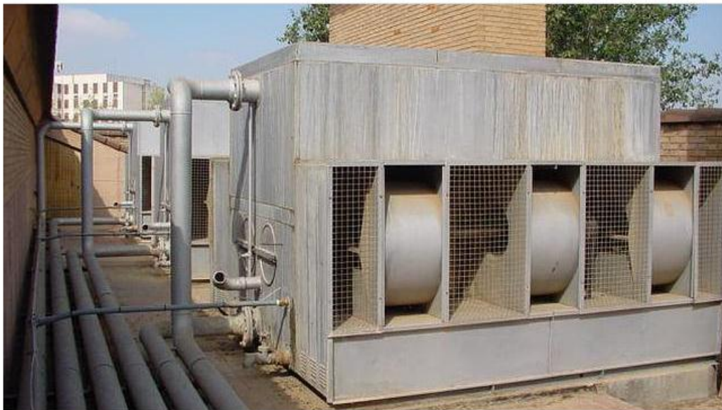
Torres de refrigeración y condensadores evaporativos
