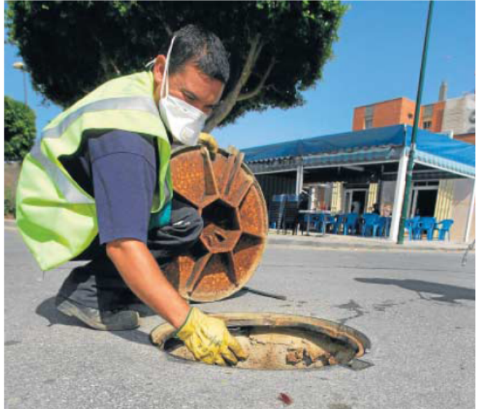
Campaña de desinfección en las alcantarillas.
