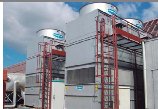
Mejoras técnicas en torres de refrigeración
