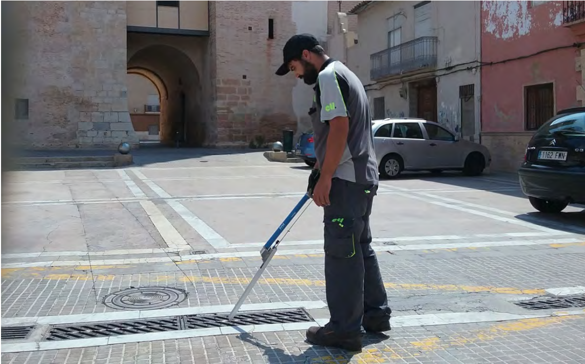
Foto 36. Tratamiento en red de pluviales
